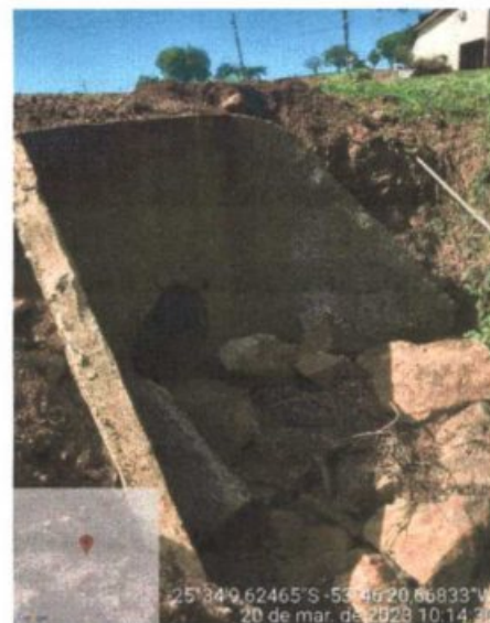
FOTO 5- OBRA DE ARTE CORRENTE TRECHO 01
