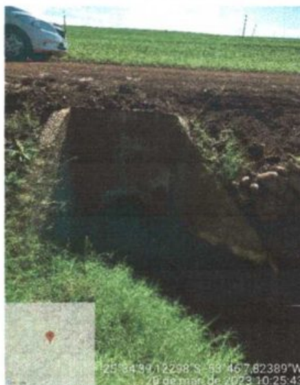
FOTO 5- OBRA DE ARTE CORRENTE TRECHO 04
