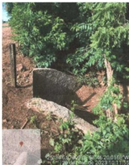
FOTO 3- OBRA DE ARTE CORRENTE TRECHO 01
